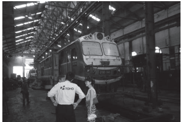
東邦 SF ポリカ窓取付中
